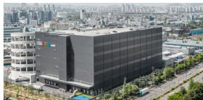
부천저온 물류센터 연면적 58,264m 2 | 준공연도 2019.07
